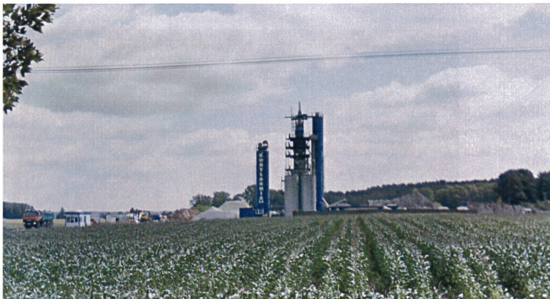
Fot. 2 Wytwórnia mas bitumicznych w miejscowości Bogusławice
