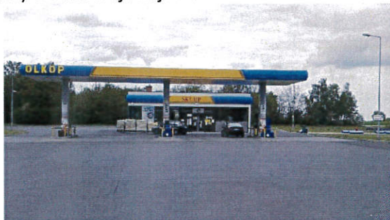
Zdjęcie 13 stacja paliw w Unisławicach
