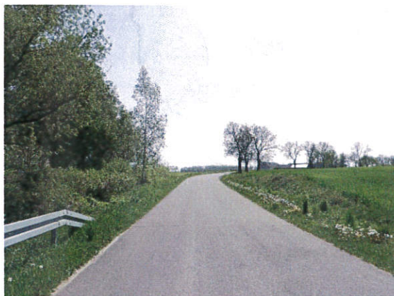
Zdjęcie 9 Droga powiatowa nr 2920C w Bogusławicach
